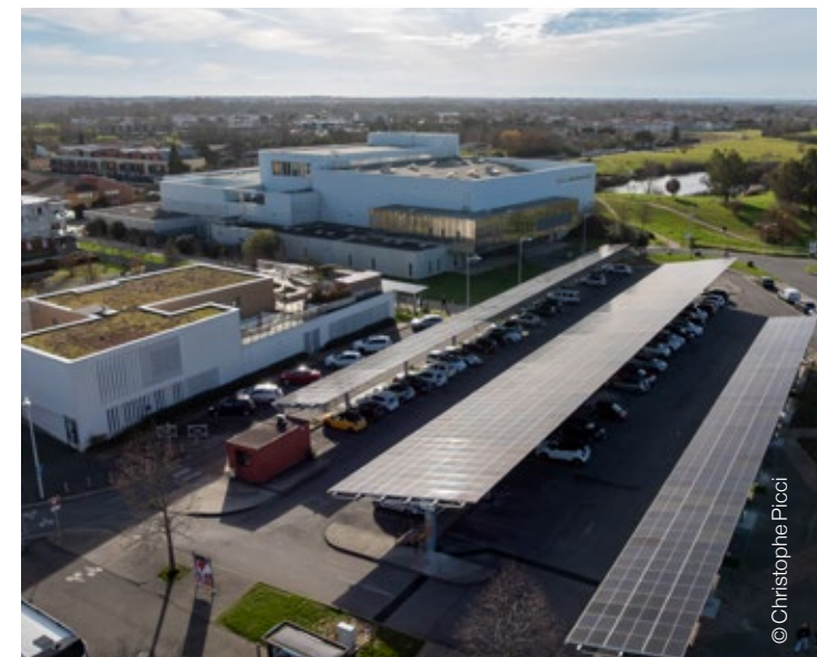
Ombrières photovoltaïques installées sur le parking de l'espace sportif des Quefets à Tournefeuille.
